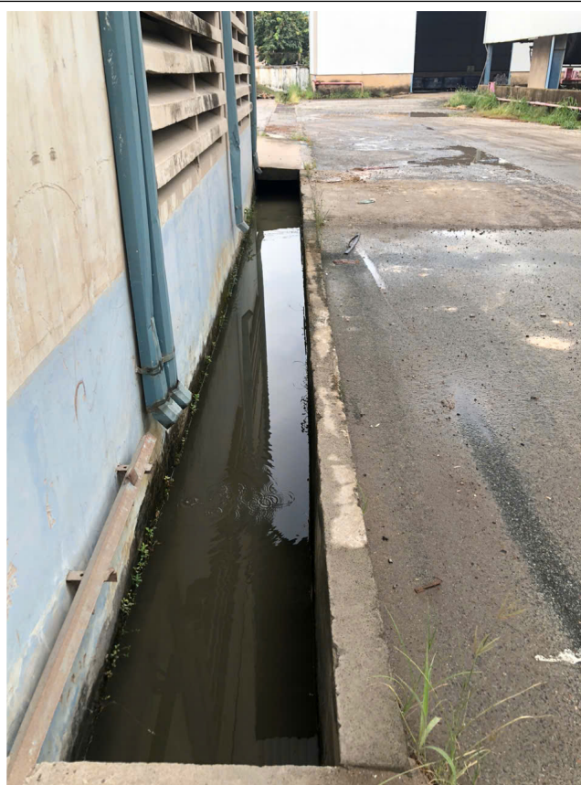
Hố ga và mương thu gom nước mưa của nhà máy
